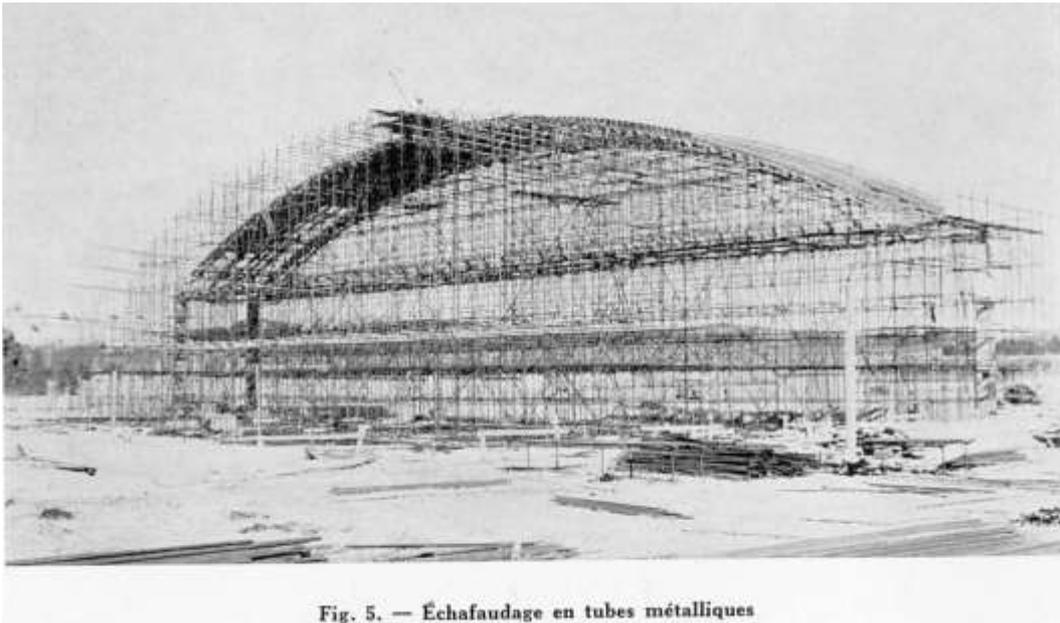
Fig. 5. — Échafaudage en tubes métalliques
