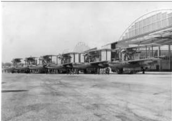
*1935 : les six hangars mesuraient 60 m x 55 m (3300 m<sup>2</sup>) et 21 m de hauteur.*
