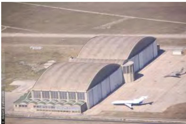
Au niveau technique Nicolas Esquillan avait conçu une couverture autoportante réalisée par une succession de voûtes, ou ondes de 100 m de portée, à double courbure pour éviter le flambement ; ces ondes seraient à la fois porteuses et couvrantes.
